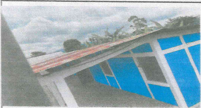
Foto 3: Sustitución de lámina por lámina troquelada
