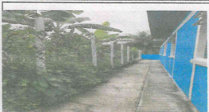
Foto 2: Sustitución de muro perimetral de malla por muro perimetral de block
