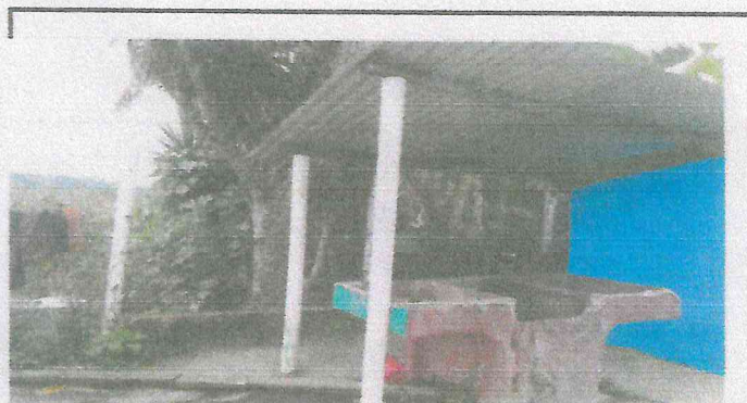
Foto 4: Sustitución de pila por tanque con lavadero
