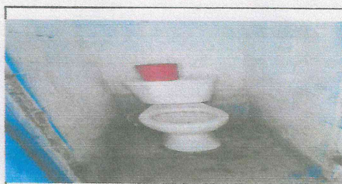
Foto 6: Sustitución de inodoro
